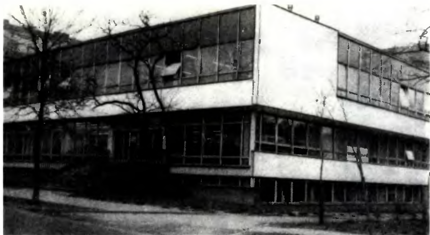
Fot. 9. Miejska Biblioteka Publiczna w Sosnowcu. Zwraca uwagę podwyższony poziom parteru i wykorzystanie przyziemia na funkcje pomocnicze.
