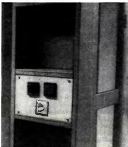
Fot. 19. Zaprojektowana przez S. Fijałkowskiego przystawka instalacyjna do regalu magazynowego produkcji „Bistyp”. Widoczne na zdjęciu przyciski służą do włączenia oświetlenia danej sekcji magazynu o powierzchni jednego makromodułu (36 m 2 ). Ponadto w przystawce znajduje się gniazdo elektryczne, pozwalające przyłączyć urządzenia zasilane prądem 220 V 50 Hz.
