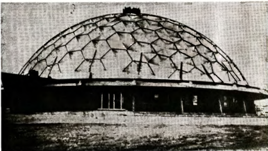
Hala przykryta kopułą z tworzywa sztucznego
