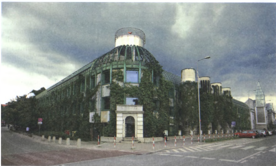
Biblioteka Uniwersytecka w Warszawie: fasada budynku głównego od ul. Lipowej i Wybrzeża Kościuszkowskiego
