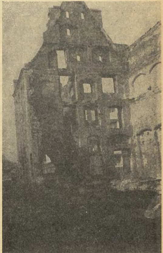
Ruiny zabytkowej kamienicy, w której — po odbudowaniu — znajdzie pomieszczenie PiMBP w Stargardzie
