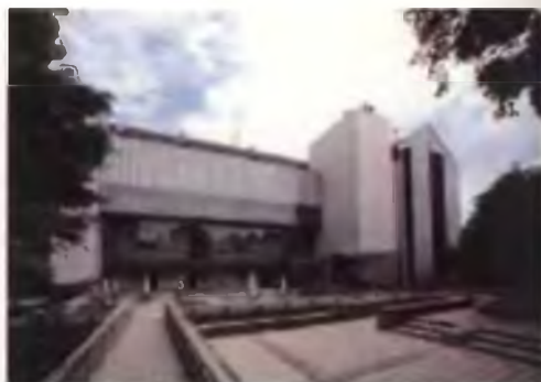
Widok budynku od tyłu. Lekka konstrukcja i szklane tafle nowoczesnej dobudowy zapewniają możliwość zobaczenia oryginalnej elewacji budynku
