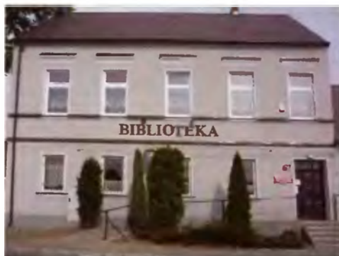
Budynek biblioteki w Baszkowie
