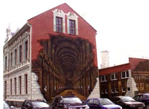
Budynek MBP w Ustroniu po remoncie z imponującym murem
