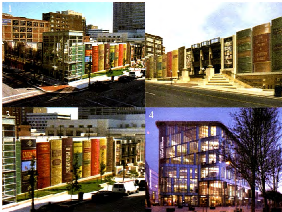
Fot. 2. Budynki biblioteczne z „książkowymi” i „półkowymi” fasadami
