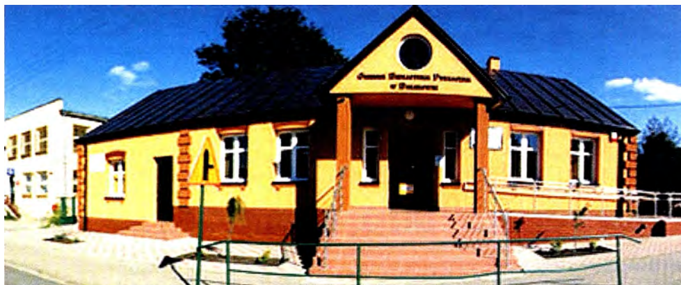
Wyremontowany budynek GBP w Dalikowie
