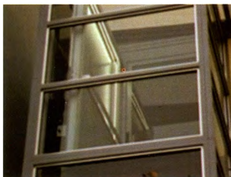
Winda dla niepełnosprawnych
