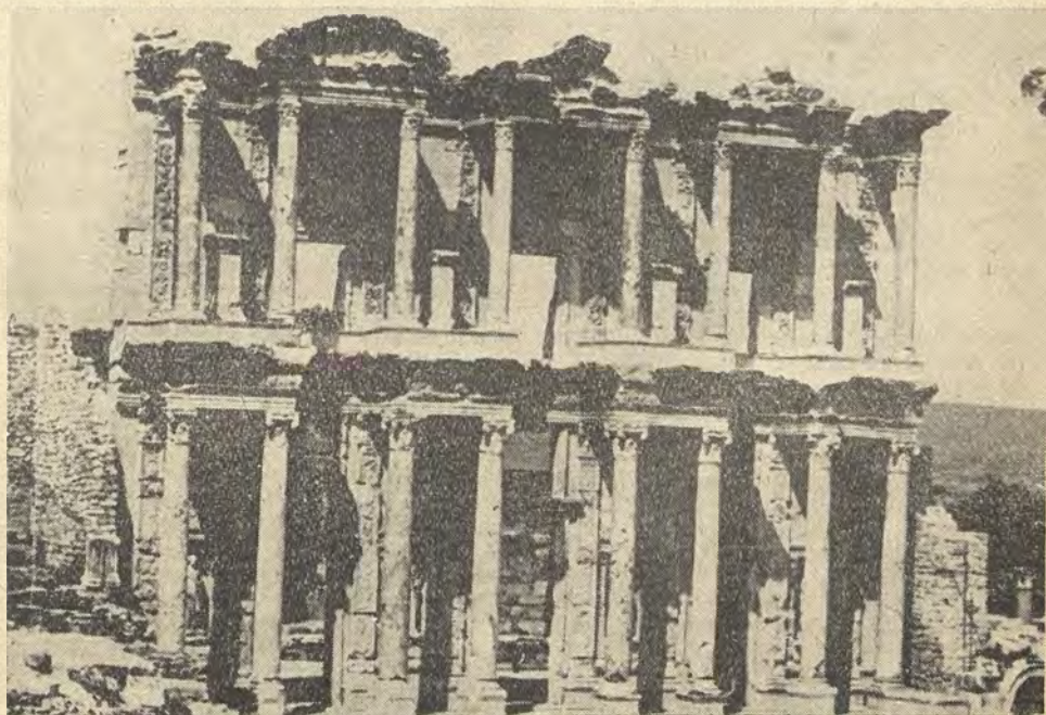
Rekonstrukcja fasady biblioteki w Efezie.
