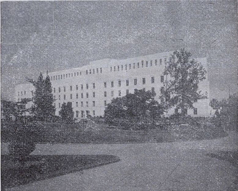
Nowy budynek Biblioteki Kongresu (annex)
