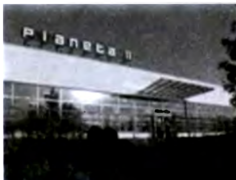
Widok zewnętrznej części Planety 11
