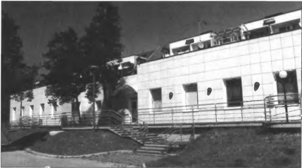
Widok biblioteki od strony parku z podjazdem dla osób niepełnosprawnych
