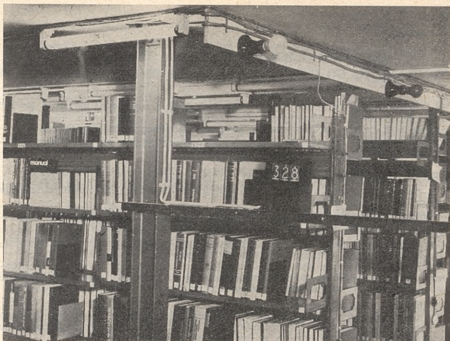
Sygnalizacja świetlna w postaci 3 ostatnich cyfr sygnatury książki uruchamiana na regale w magazynie, po wybraniu sygnatury książki na bibliofonie przez czytelnika
