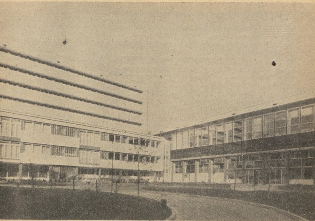
Widok biblioteki od strony ogrodu. Z prawej strony na parterze dział dziecięcy, na I p. czytelnia ogólna. Z lewej strony na pierwszym planie trakt mieszczący akcesje, kierownictwo biblioteki i mieszkania służbowe; w głębi magazyn książek.
