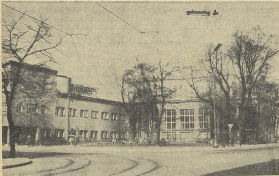
Miejska Biblioteka Publiczna im. L. Waryńskiego w rozbudowie. Projektant dr archit. Jerzy Wierzbicki
