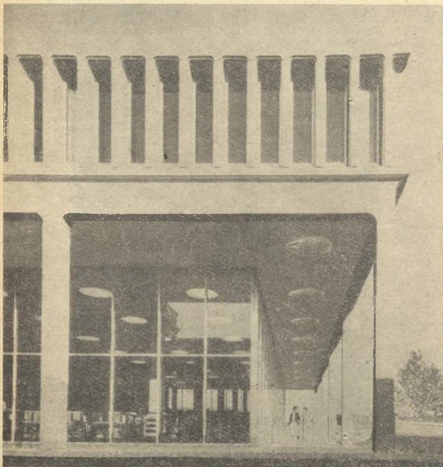
rys. 4. Fragment biblioteki. Z prawej strony na pierwszym planie równia pochyla wejściowa o łagodnym spadku.
