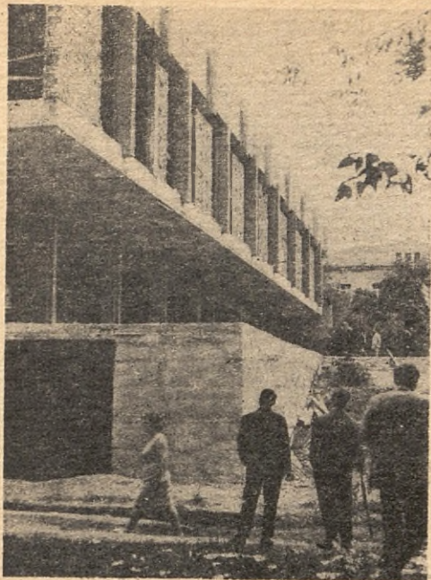
Plovdiv — Bułgaria. Okręgowa Biblioteka Ludowa w budowie Fot. St. Fijałkowski
