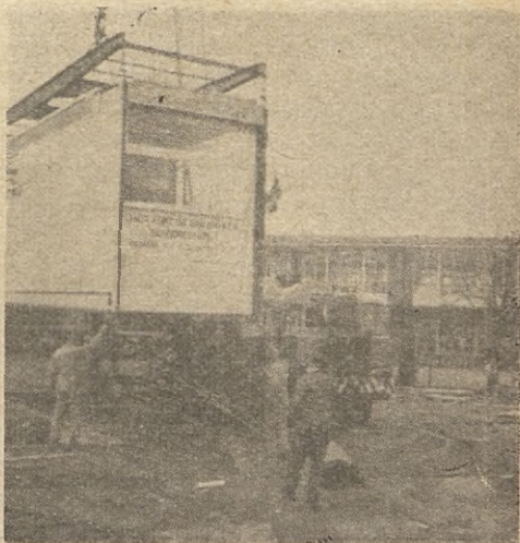
Budowa biblioteki w Benoordenhout. Segment na transporterze.
