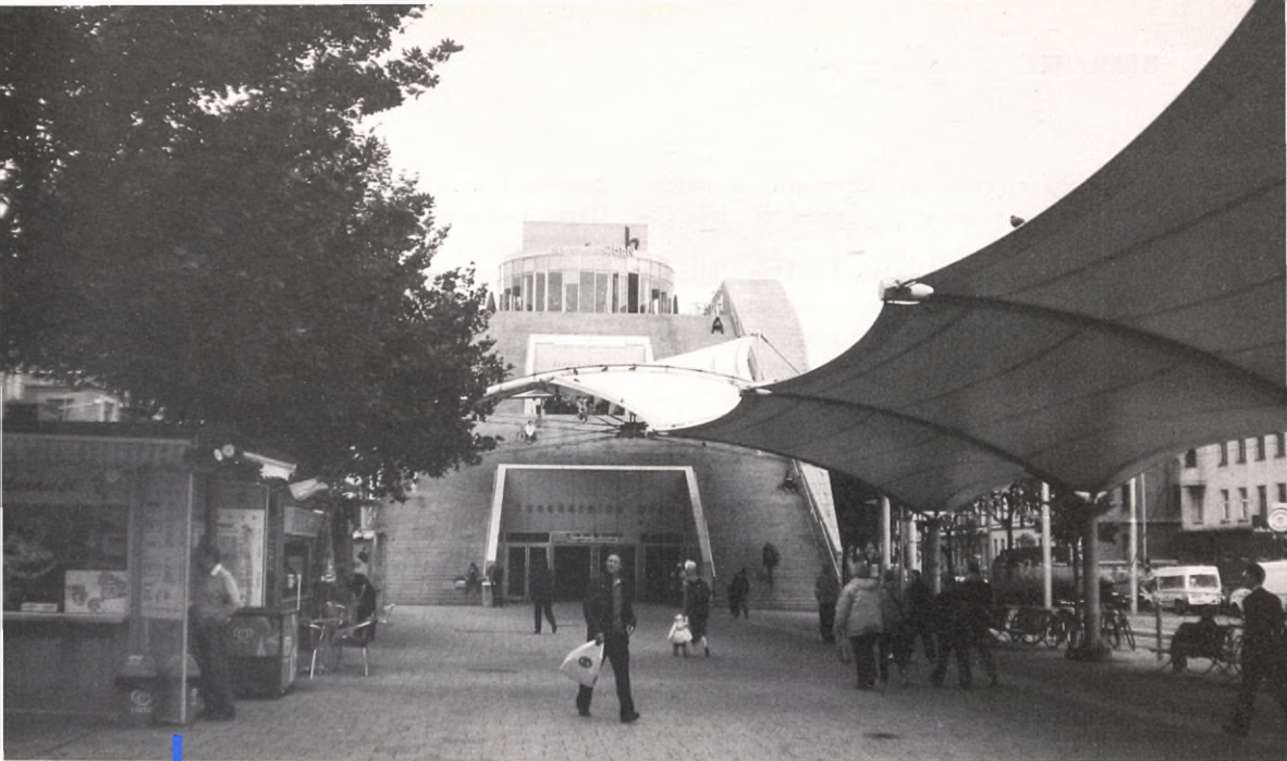
Biblioteka – widok z drugiej strony. U dołu linia metra Fot. Autor
